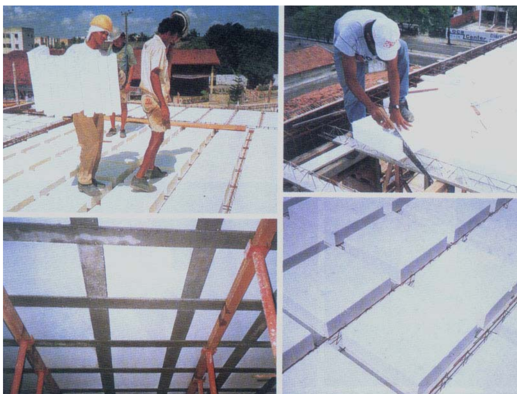
Figura 17.7 – Blocos de EPS com vigotas treliçadas (FRANCA & FUSCO, 1997)
