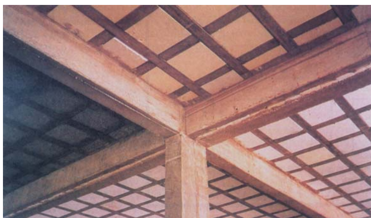
Figura 17.1 – Laje nervurada bidirecional (FRANCA & FUSCO, 1997)
