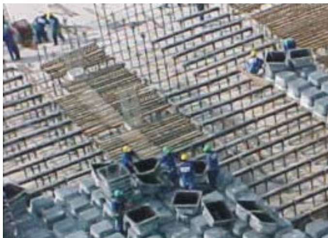
Figura 17.3 – Laje nervurada moldada no local
