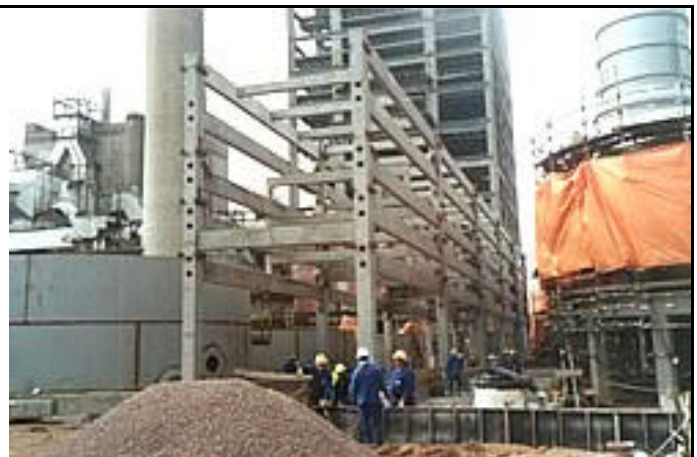
FIGURA 6: Detalhe de construção pré-fabricada em ambiente industrial (ABCIC, 2005)
