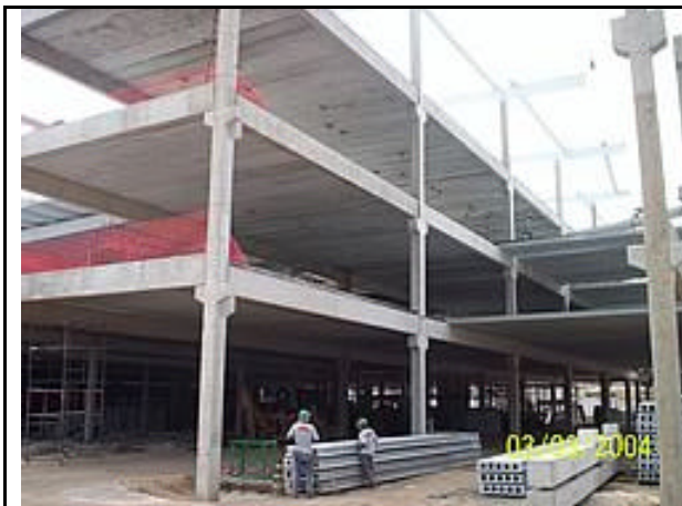
FIGURA 5: Detalhe de obra com utilização de vigas, pilares e lajes alveolares pré-moldadas (ABCIC, 2005)
