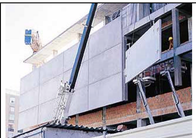
FIGURA 8: Painéis arquitetônicos de GFRC (concreto reforçado com fibra de vidro) (CORBIOLLI, 2001)
