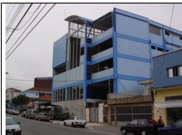
FIGURA 9: Estrutura em Pré-fabricado agregado à Estrutura Metálica
