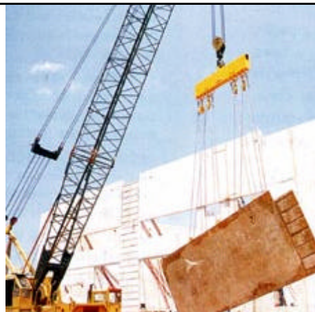
FIGURA 4: Içamento de parede executada através do sistema tilt-up (ABESC, 2005)
